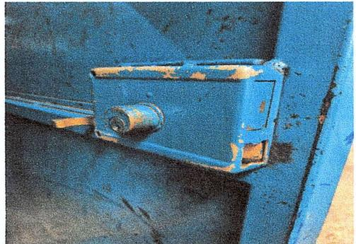
Foto 4: Se observa chapa en mal estado, se trava y no cierra.
