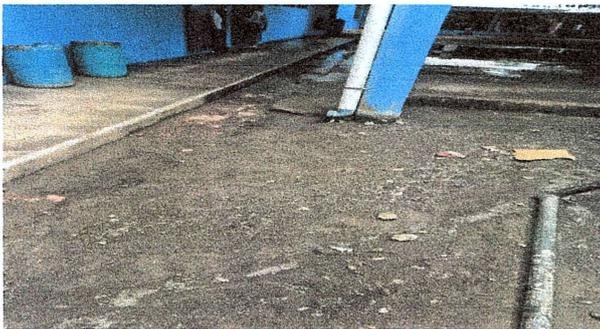
Foto 11: Se observa que urge reparación de torta de concreto en patio.
