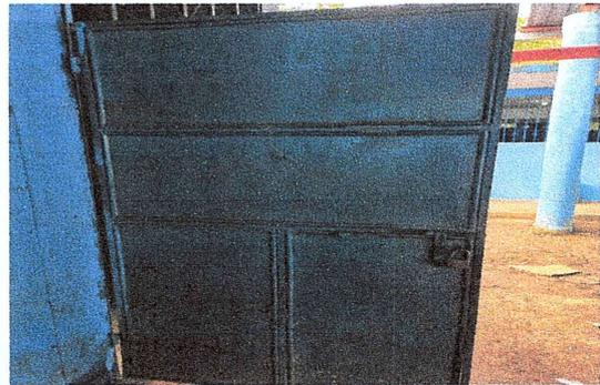
Foto 2: Se observa puertas en mal estado y avanzada corrosión y lámina dañada.
