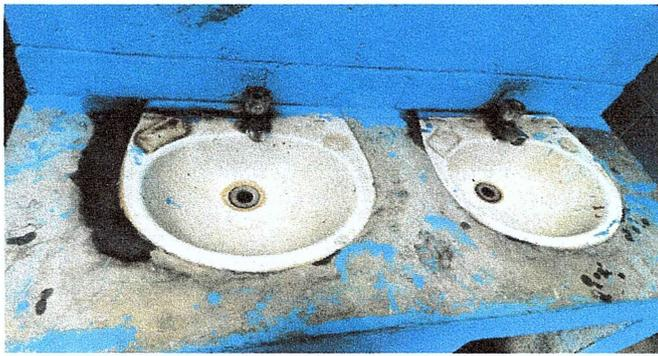
Foto 9: Se observa lavamanos deteriorados y en mal estado urge sustituirlos.
