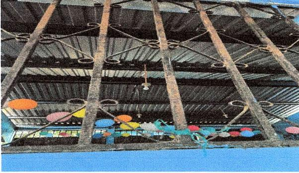
Foto 7: Se observa falta de mantenimiento y corrosión en blacones de metal en aulas.
