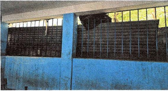
Foto 3: Se observa la falta de ventanas de vidrio para detener el ingreso de agua.
