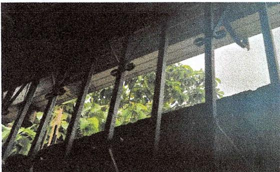
Foto 5: Se observa canal sin caída y daño en soporte.
