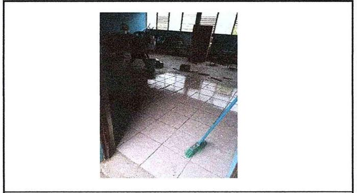
FOTO 2: SE VISUALIZA QUE INICIARON LOS TRABAJOS DE COLOCACIÓN DE PISO CERÁMICO.
