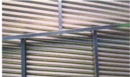
**Foto 2:** Se observa el mejoramiento y fortalecimiento de la estructura del techo del área de bodega para evitar que colapse sobre los niños
