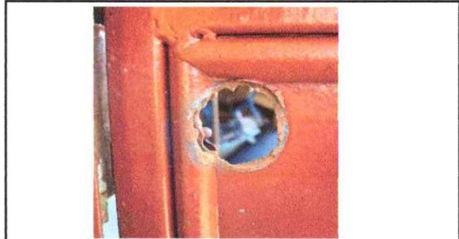
Foto 7: Se observa el estado de las chapas de las puertas para hacer los cambios
