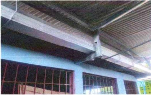
**Foto 3:** Se observa la reparación y cambio del canal de plástico
