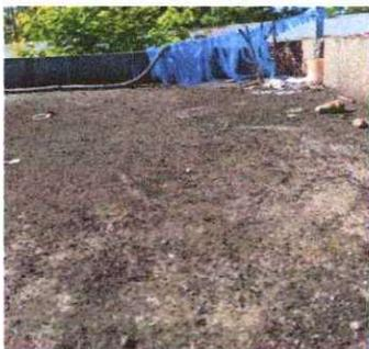
Foto 5: Se observa el desnivel en la terraza, necesitando la reparación de pañuelos
