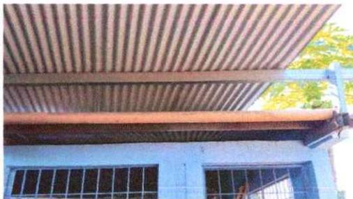
Foto 3: Se observa el mal estado del canal de plástico sin bajadas ni accesorios
