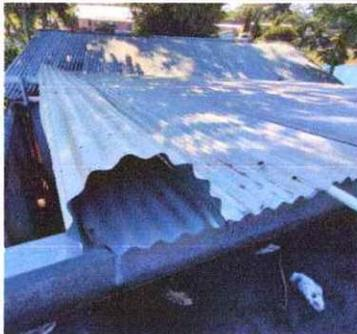
Foto 1: Se observa el estado de la lámina del área de bodega para resguardo de lluvia y evitar que colapse sobre los niños
