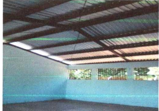
Foto 2: *se observa el cambio del modulo y el pintado del interior*
