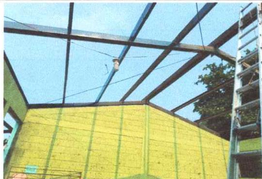
Foto 1: *Se observa el cambio de lámina de los módulos deteriorados*
