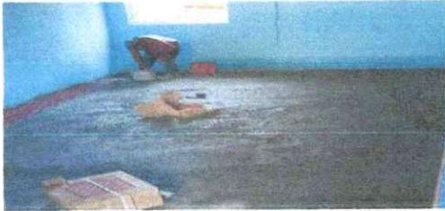
Foto 1: Se observa que se está colocado piso cerámico en aulas
