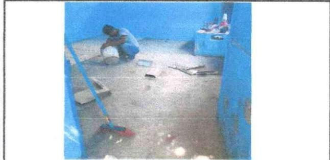
Foto 10: se observa que se está realizando la colocación de piso cerámico en el área de cocina.
