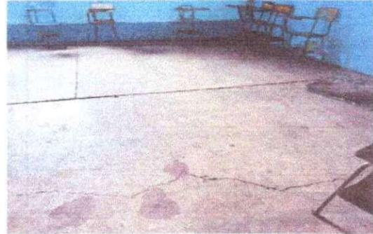
Foto 2: Se Observa el mal estado del piso por lo que se necesita su sustitucion y mejora
