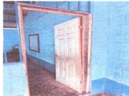
Foto 4: Se Observa la necesidad del Cambio de Puerta debido a que el material que cuenta esta defectuoso
