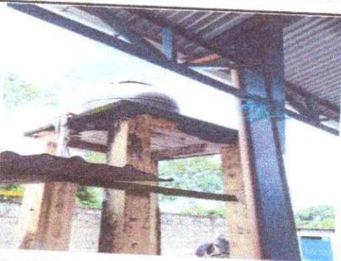
Foto 9: Se observa la necesidad de la sustitución del depósito de agua
