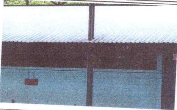
Foto 7: Se observa la necesidad de la instalación de canales de PVC para evitar que el agua pluvial entre en las aulas
