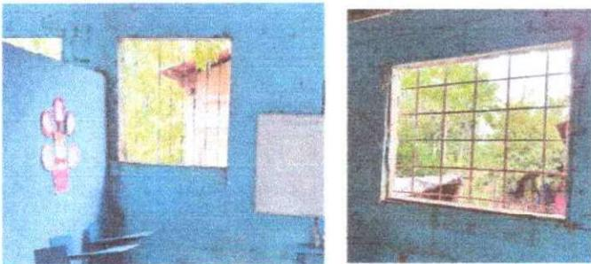
Foto 5: Se observa la necesidad de cambio de balcones debido al deterioro por corrosion.
