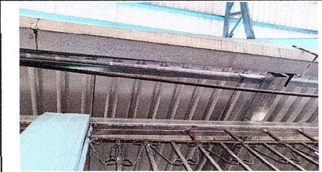
Foto 7: Se observa lámina totalmente nueva
