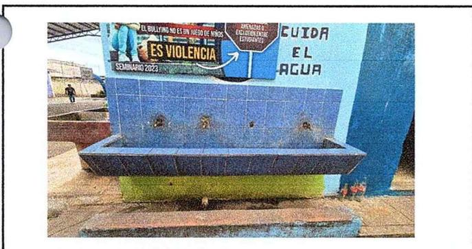
Foto 5: Se observa lavamanos de concreto y azulejo en mal estado y con falta de accesorios
