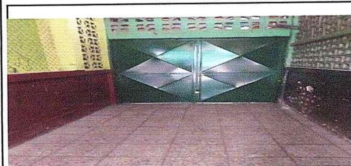
Foto 5: Se observa que la puerta de madera fue sustituida por una de metal y al ingreso del salón de clases, se le sustituyó por piso de granito.
