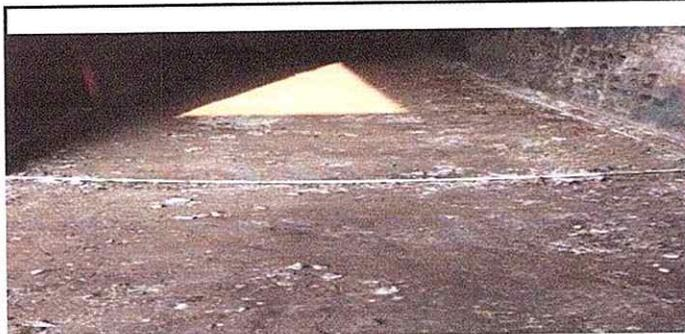
Foto 5: Se observa que el piso deteriorado fue levantado.
