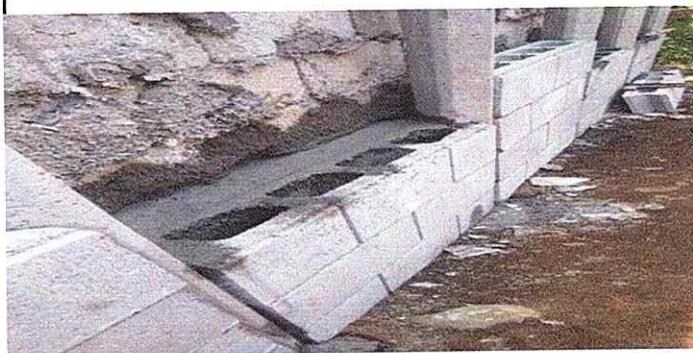
FOTO 1: Se observa que están instalando el muro perimetral prefabricado.
