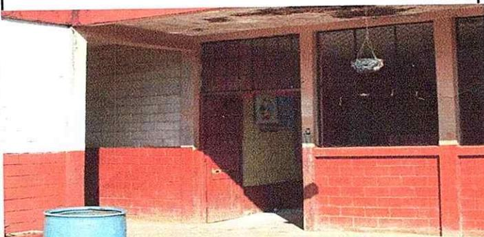
FOTO 3: Se observa que las puertas de las aulas están muy deterioradas.
