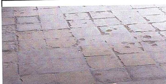
FOTO 4: Se observa que el piso de ingreso a 2 aulas está deteriorado y se está hundiendo.
