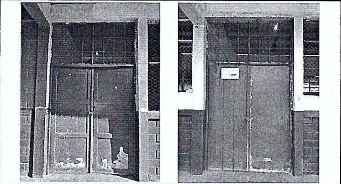
Foto 4: Se observa las puertas del módulo de aulas en mal estado, urge su sustitución.
