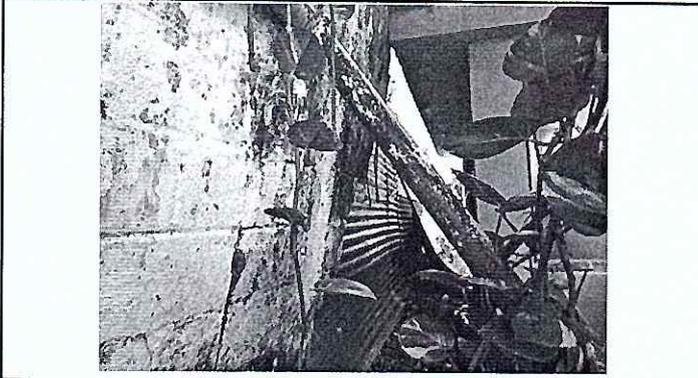
Foto 1: Se observa un tramo del muro perimetral inclinado, el cual está apuntalado por una estructura de metal (marco de futbol)
