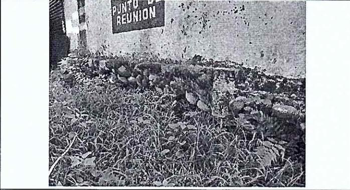
Foto 3: Se observa que otro tramo del muro perimetral tiene daños en su cimiento de piedra, urge su reparación y protección
