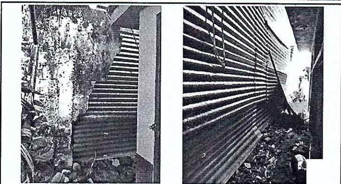
Foto 2: Se observa que otro tramo del muro perimetral, ya colapsó
