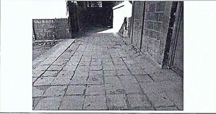
Foto 5: Se observa hundimiento en un área, es necesario sustituir el piso existente
