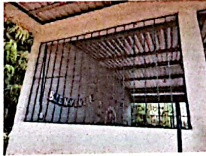
Foto 8: FOTOGRAFIA SUMINISTRO E INSTALACION BALCONES
