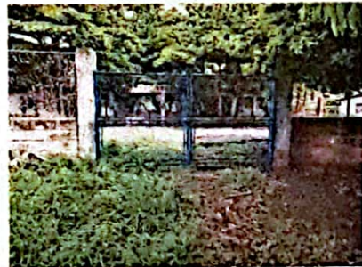
Foto 12: FOTOGRAFIA SUMINISTRO E INSTALACION DE PORTON
