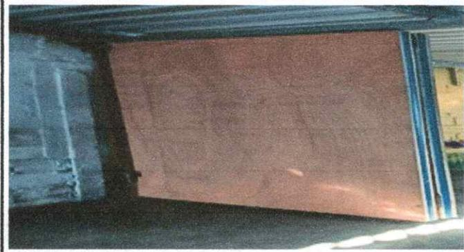
Foto7: SE OBSERVA QUE SE SUSTITUYO LA DIVISIÓN DE ENTREPAÑO DE METAL Y PLYWOOD EN MÓDULO 3.
