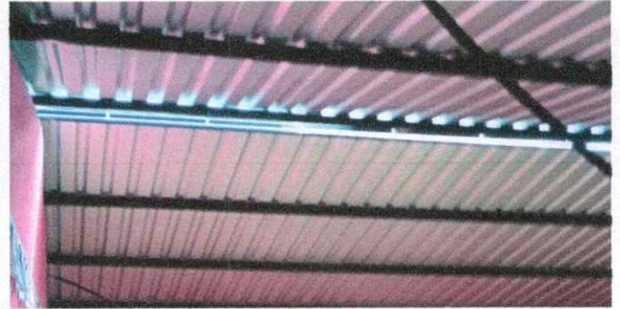
Foto 2: SE OBSERVA LA SUSTITUCIÓN DE LA ESTRUCTURA DE SOPORTE DE METAL.
