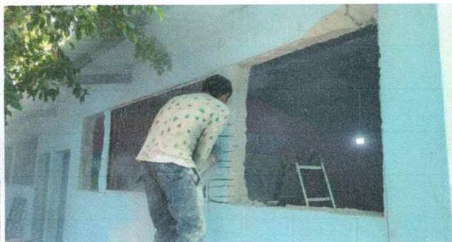
Foto 3: SE OBSERVA QUE SE ESTÁ AMPLIANDO LAS VENTANAS DEL MÓDULO 1.
