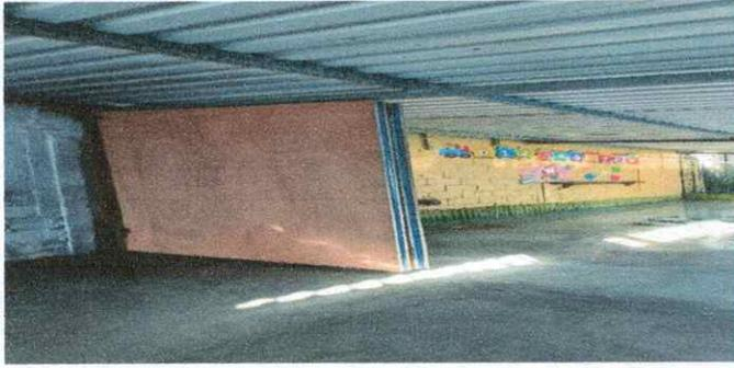
Foto 7: SE OBSERVA QUE SE ESTÁ INSTALANDO UNA DIVISIÓN DE DOS AULAS SERÁ REEMPLAZADO POR ENTREPAÑO DE METAL Y PLYWOOD EN EL MÓDULO 3.
