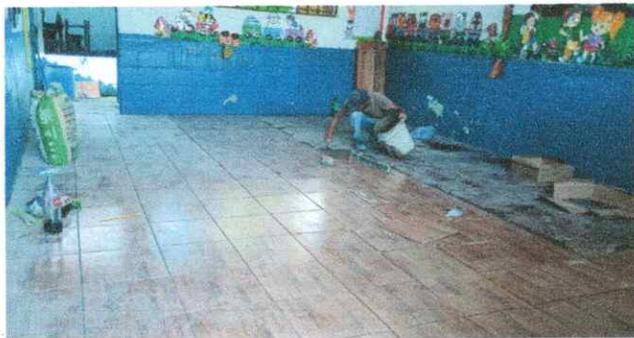
Foto 5: SE OBSERVA QUE SE ESTÁ REALIZANDO LA SUSTITUCIÓN DE PISO CERÁMICO AL MÓDULO 2.
