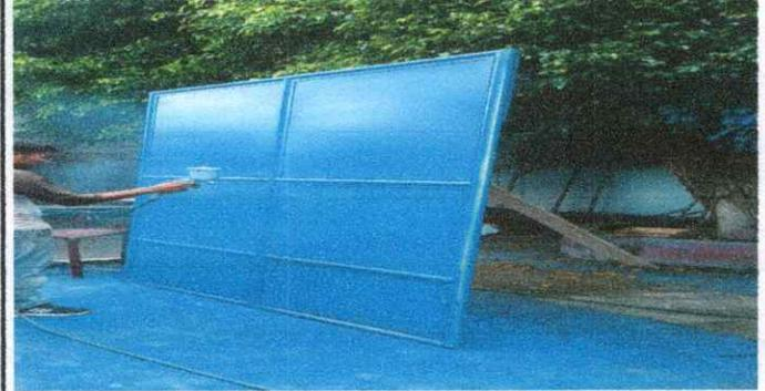
Foto 8: SE OBSERVA QUE SE ESTÁ TRABAJANDO EN EL PORTON POR DAÑOS DE ÓXIDO Y PICADURAS.
