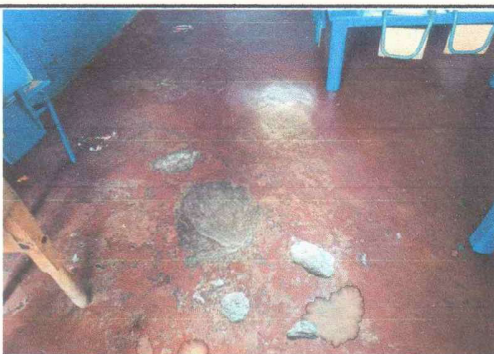
Foto 5: Se observa piso del módulo 2 dañado, en algunas partes con hundimiento y agujeros.
