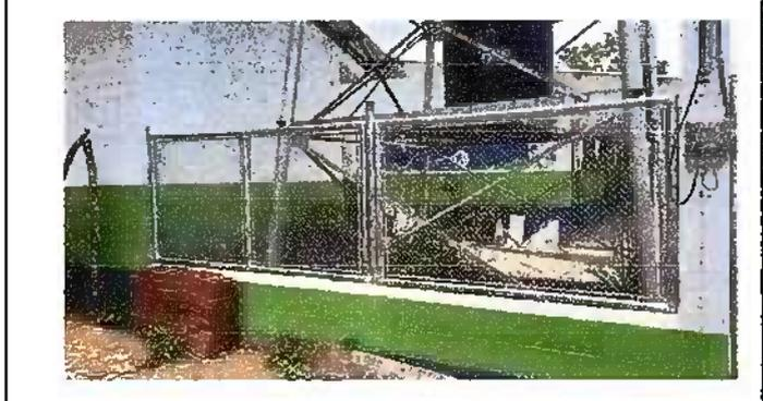
Foto 8: Modulo 3: Reparación de muro perimetral de block con tubo hg y malla galvanizada, soleras intermedias y columnas
