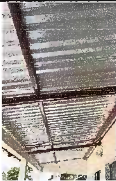
Foto 11: Modulo 1: Mantenimiento a estructura de soporte de metal
