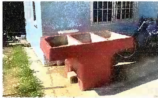
Foto 10: Modulo 4: Sustitución de pila de cemento de dos lavadero
