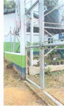
Foto 8: Modulo 3: Reparación de muro perimetral de block con tubo hg y malla galvanizada, soleras intermedias y columnas
