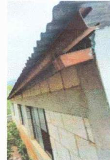
Foto 12: Modulo 1: Sustitución de estructura de soporte de metal, por metal
