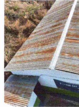
Foto 2: Modulo 1: Sustitución de lámina, por lámina troquelada aluzinc calibre 26
