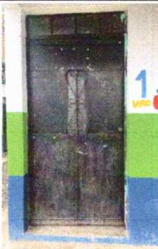
Foto 5: Modulo 1: Mantenimiento a estructura de puerta (lijado, cambio de tubo, cepillado, sujeciones, aplicación de pintura)
