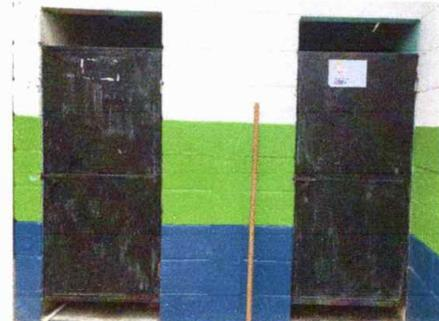
Foto 6: Modulo 2: Mantenimiento a estructura de puerta (lijado, cambio de tubo , cepillado, sujeciones, aplicación de pintura) a puertas servicios sanitarios
