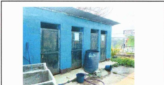
Foto 4: Modulo 2: Mantenimiento a estructura de puerta (lijado, cambio de tubo , cepillado, sujeciones, aplicación de pintura) a puertas servicios sanitarios
