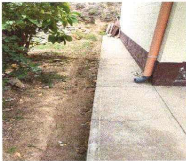
Foto 5: Modulo 2: Reparación de bajada de agua pluvial, tubo PVC 3"
