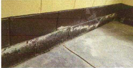
Foto 1: Modulo 1: Sustrucción de piso cerámico
