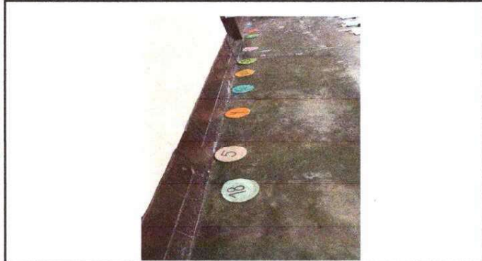
Foto 7: Modulo 3: Sustrucción de piso cerámico
