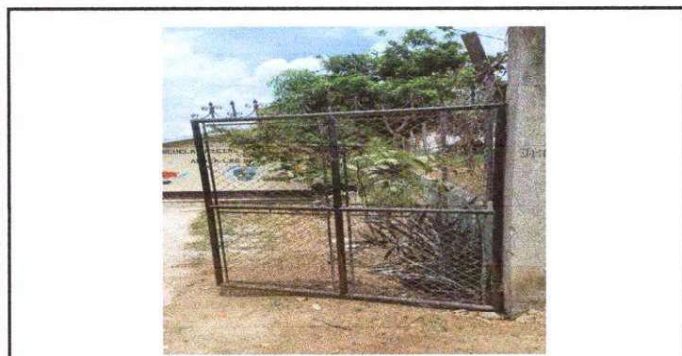
Foto 11: Portón de Ingreso
