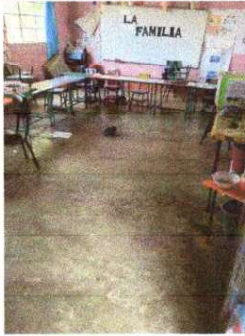
Foto 3: Modulo 2: Sustrucción de piso cerámico
