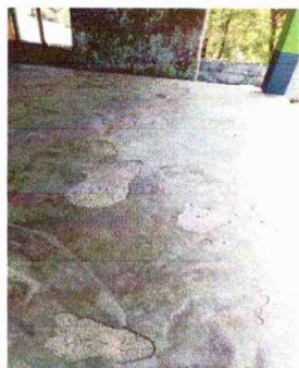
Foto 1: Modulo 1: Sustitución de piso cerámico
