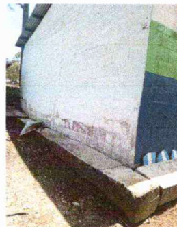
Foto 2: Modulo 1: Reparación de banquetas de concreto
