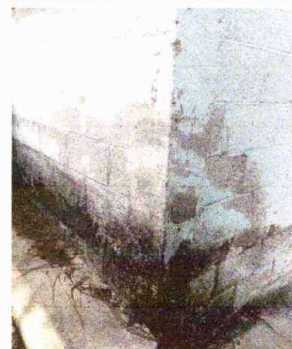
Foto 4: Modulo 1: Cernido en muro
