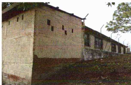
Foto 3: Modulo 1: Pintura en muros exteriores e interiores
