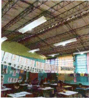
Foto 1: Modulo 1: Sustitución de lámina, por lámina troquelada aluzinc calibre 26
