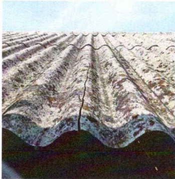
Foto 3: Modulo 1: Sustitución de capote de lámina para lámina troquelada
