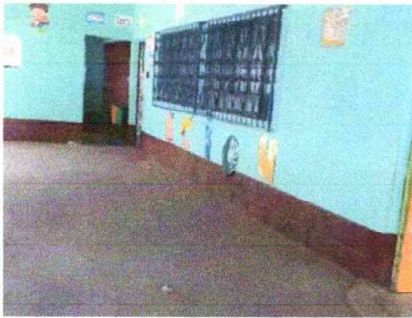
Foto 5: Modulo 1: Pintura en muros exteriores e interiores
