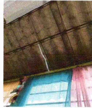
Foto 4: Modulo 1: Instalación de estructura portante de metal
