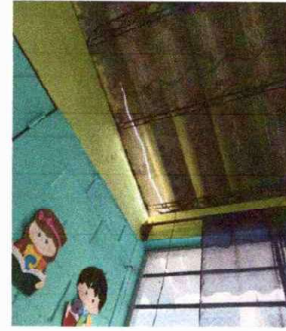
Foto 2: Modulo 1: Sustitución de lámina, por lámina troquelada aluzinc calibre 26
