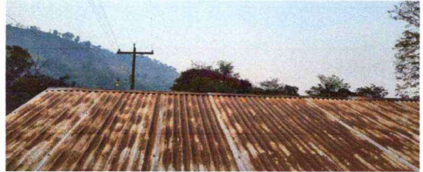
Foto 2: Modulo 1: Sustitución de lámina, por lámina troquelada aluzinc calibre 26
