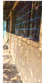
Foto 4: Modulo 1: Pintura en muros exteriores e interiores
