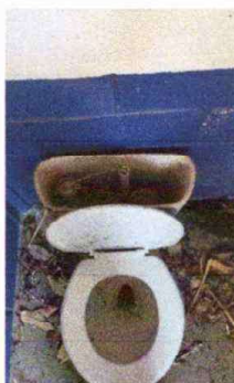
Foto 5: Modulo 2: Sustitución inodoro
