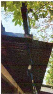
Foto 3: Modulo 1: Instalación de estructura portante de metal
