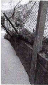
Foto 7: Muro Perimetral: Reparación de muro de block
