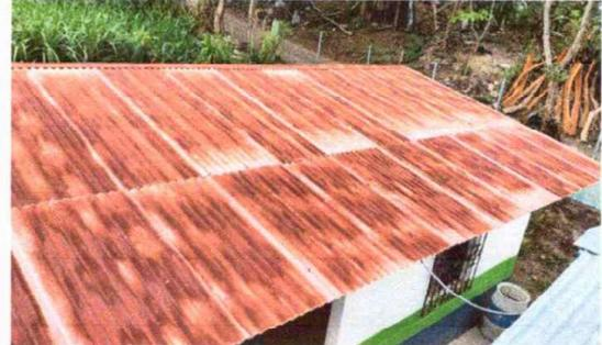
Foto 10: Modulo 4: Instalación de lámina troquelada aluzinc
