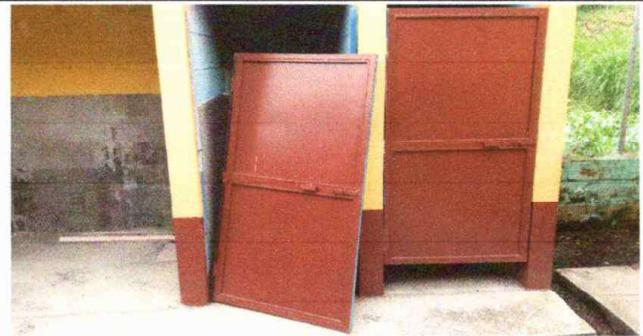
Foto 6: Modulo 3: Mantenimiento a estructura de puerta (lijado, cambio de tubo, cepillado, sujeciones, aplicación de pintura) a puertas servicios sanitarios
