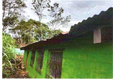
Foto 8: Modulo 4: Sustitución de lámina, por lámina troquelada aluzinc calibre 26
