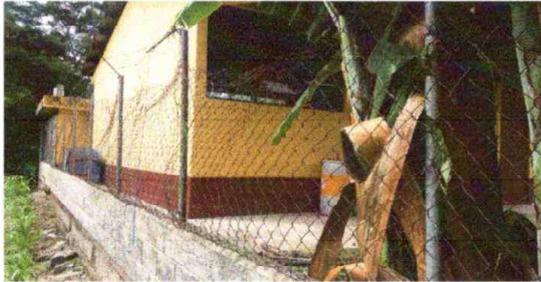
Foto 1: Modulo 1: Reparación de muro perimetral de block con tubo hg y malla galvanizada, soleras intermedias y columnas
