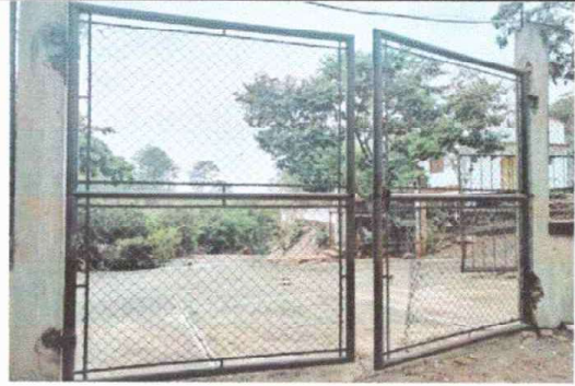
Foto 8: Muro Perimetral: Sustitución de portón (3.40x2.30)
