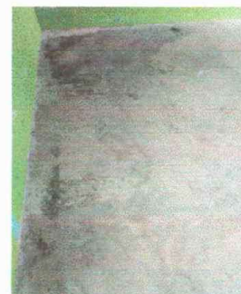
Foto 6: Modulo 2: Sustitución de piso cerámico
