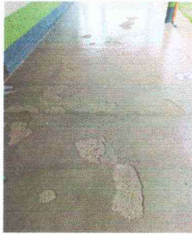
Foto 1: Modulo 1 Sustitución de piso cerámico
