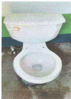
Foto 3: Modulo 1: Sustitución inodoro
