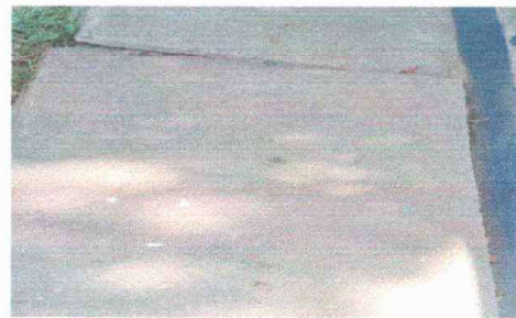
Foto 4: Modulo 1: Reparación de banquetas de concreto
