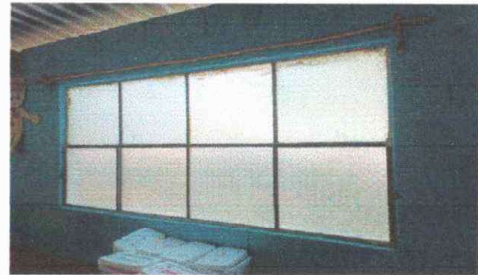
Foto 2: Modulo 1: Suministro e instalación de balcones de metal
