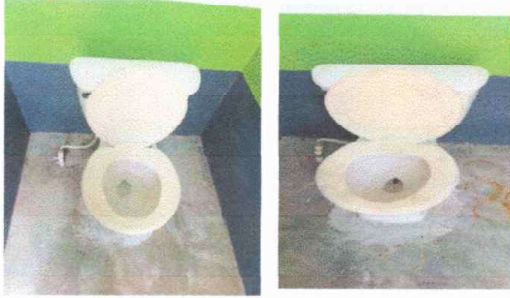
Foto 7: Modulo 2: Sustitución inodoro
