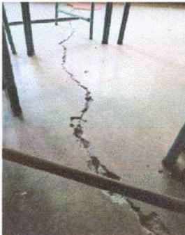
Foto 3: Modulo 1: Sustitución de piso cerámico
