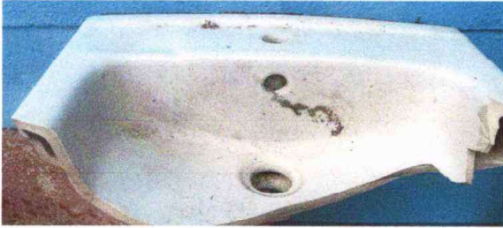
Foto 7: Modulo 7: Sustitución lavamanos
