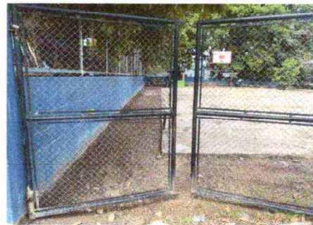
Foto 10: Modulo 3: Sustitución de portón de metal
