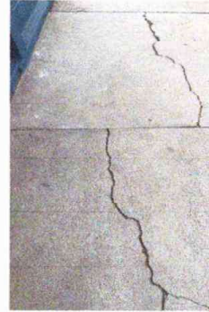
Foto 8: Modulo 2: Sustitución de piso cerámico
