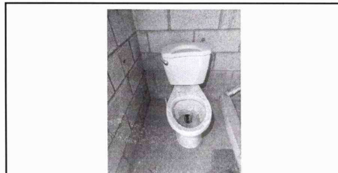
Foto 6: Módulo 2: Sustitución de accesorios inodoro (contra llave, tubo de abasto y tanque)
