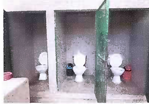
Foto 4: Modulo 2: Instalación de inodoro
