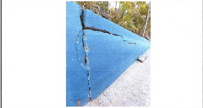
Foto 1: Modulo 1: Reparación de muro de contención
