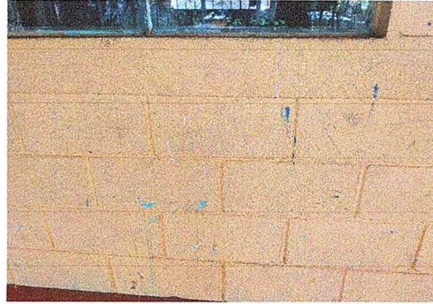
Foto 8: Modulo 3: Pintura en muros exteriores e interiores
