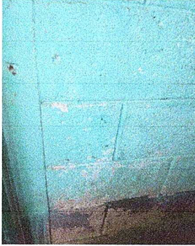
Foto 7: Modulo 3: Pintura en muros exteriores e interiores
