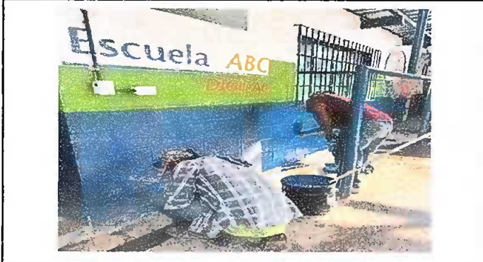
Foto 1: Modulo 1: Pintura en muros exteriores e interiores
