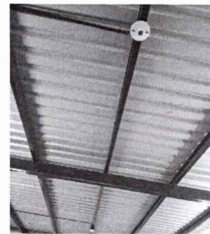
Foto 4: Modulo 1: Sustitución de focos ahorradores
