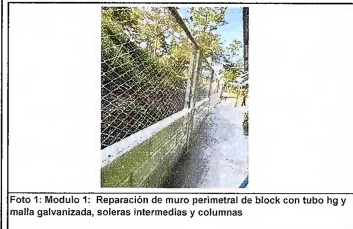
Foto 1: Modulo 1: Reparación de muro perimetral de block con tubo hg y malla galvanizada, soleras intermedias y columnas
