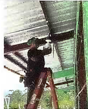
Foto 4: Modulo 2: Sustitución de plafoneras
