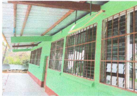
Foto 4: Modulo 2: Sustitución de plafoneras
