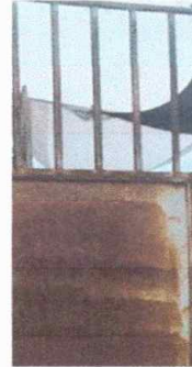
Foto 2: Modulo 1: Sustitución de portón de metal
