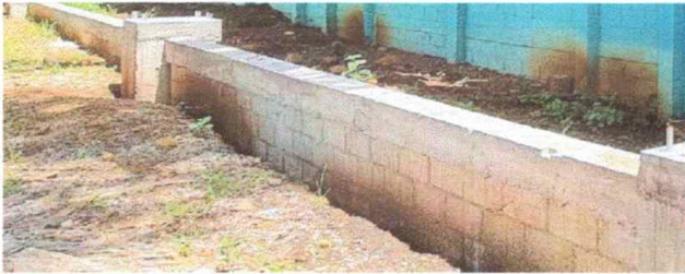
Foto 1: Modulo 1: Reparación de muro perimetral de block con tubo hg y malla galvanizada, soleras intermedias y columnas
