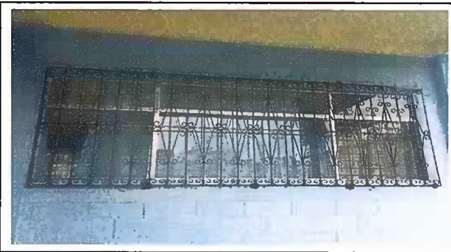
Foto 2: Modulo 1: Sustitución de balcon de metal
