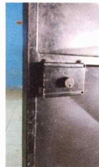
Foto 4: Modulo 1: Mantenimiento a estructura de puerta (lijado, cambio de tubo, cepillado, sujeciones, aplicación de pintura)
