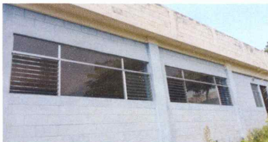
Foto 3: Modulo 1: Fabricación e instalación de balcon de hierro en ventana
