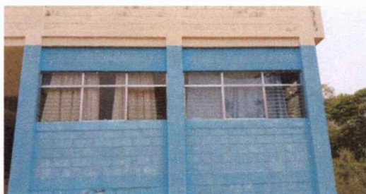
Foto 1: Modulo 1: Sustritiución de balcon de metal
