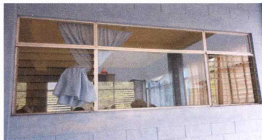
Foto 2: Modulo 1: Sustritiución de balcon de metal
