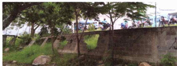
Foto 6: Modulo 2: Reparación de muro perimetral de block con tubo hg y malla galvanizada, soleras intermedias y columnas
