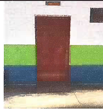
Foto 10: Modulo 2: Mantenimiento a estructura de puerta (lijado, cambio de tubo, cepillado, sujeciones, aplicación de pintura)
