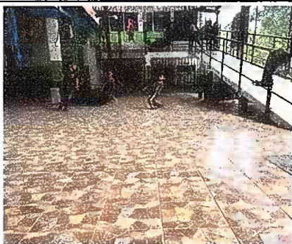
Foto 5: Modulo 2: Sustitución de piso de torta de concreto por piso cerámico
