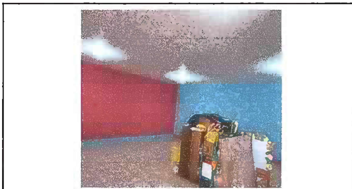
Foto 15: PINTURA GENERAL: Pintura en muros exteriores e interiores
