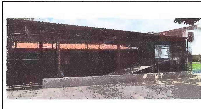
Foto 14: MURO PERIMETRAL: Reparación de muro perimetral de block con tubo hg y malla galvanizada, soleras intermedias y columnas
