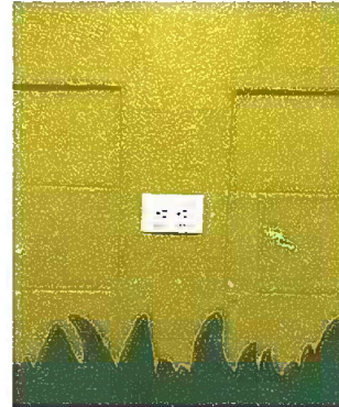
Foto 8: Modulo 2: Sustitución de tomacorrientes dobles
