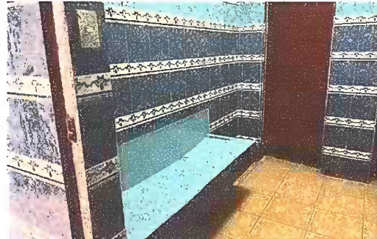
Foto 12: Modulo 3: Sustitución de azulejo
