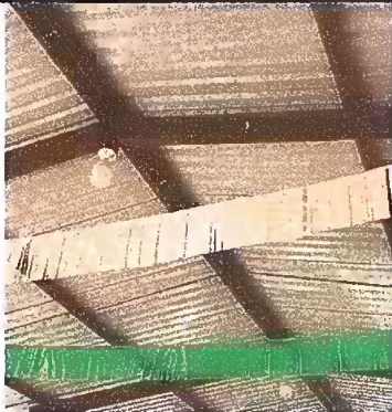
Foto 9: Modulo 2: Sustitución de focos ahorradores
