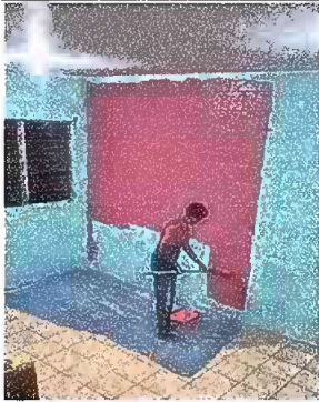
Foto 15: PINTURA GENERAL: Pintura en muros exteriores e interiores
