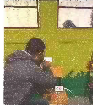
Foto 8: Modulo 2: Sustitución de tomacorrientes dobles
