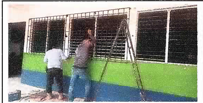
Foto 1: Modulo 1: Suministro e instalacion de balcones de metal
