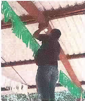
Foto 9: Modulo 2: Sustitución de focos ahorradores
