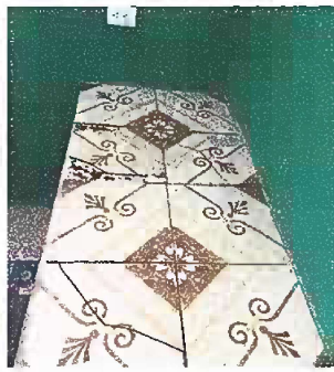
Foto 3: Modulo 1: Instalación de azulejo en estufa rural
