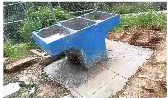
Foto 4: Modulo 1: Sustitución de pila de cemento de dos lavadero
