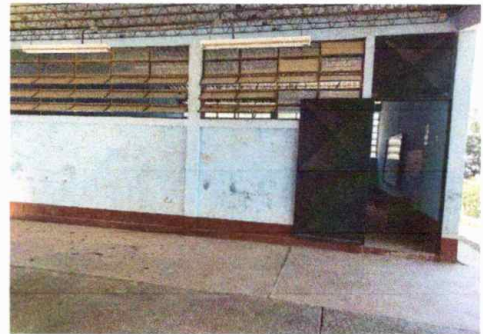
Foto 10: Modulo 2: Mantenimiento a estructura de puerta (lijado, cambio de tubo, cepillado, sujeciones, aplicación de pintura)
