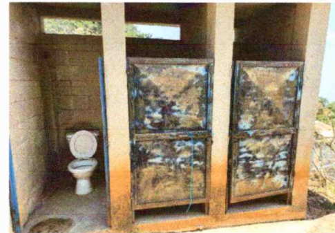
Foto 12: Modulo 3: Mantenimiento a estructura de puerta (lijado, cambio de tubo, cepillado, sujeciones, aplicación de pintura) a puertas servicios sanitarios
