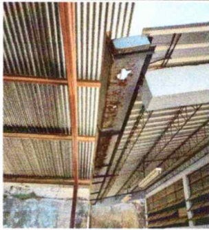
Foto 9: Modulo 2: Sustitución de canal de metal
