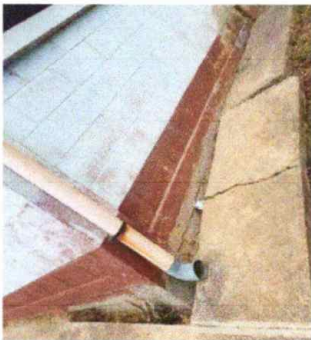
Foto 11: Modulo 2: Sustitución de bajada de agua pluvial de metal por tubo PVC 3"
