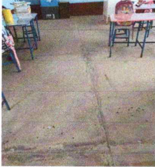
Foto 7: Modulo 2: Sustitución de piso cerámico
