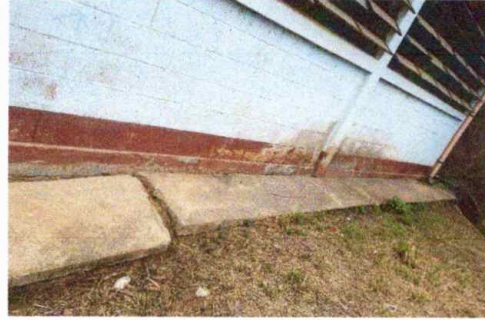
Foto 8: Modulo 2: Reparación de banquetas de concreto
