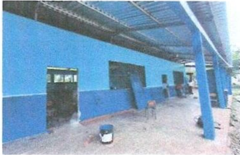
Foto 1: Sustitución de puertas de madera por metal
