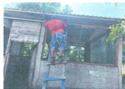
Foto 6: Sustitución de lámina por lámina troquelada calibre 26 de la cocina escolar
