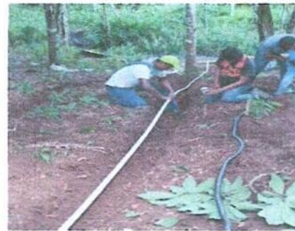
Foto 4: Instalación de tubería del pozo al centro educativo
