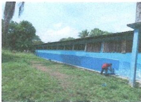
Foto 3: Pintura en muros exteriores e interiores del centro educativo
