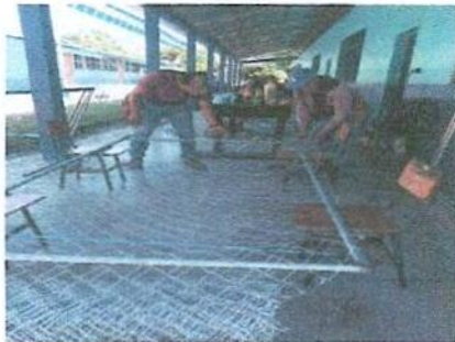
Foto 5: Reparación de tubo hg y maya galvanizada
