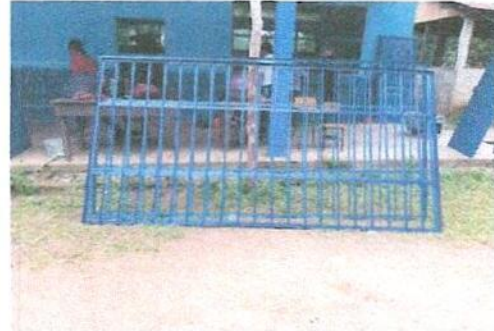
Foto 2: Sustitución de ventanas de madera con malla por balcones de metal
