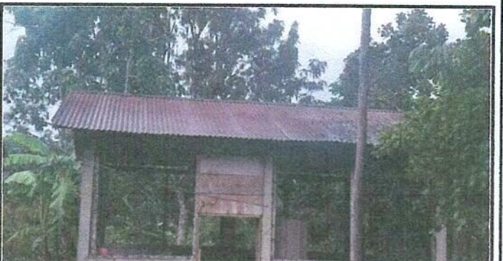
Foto 6: Sustitución de lámina por lámina troquelada calibre 26 de la cocina escolar
