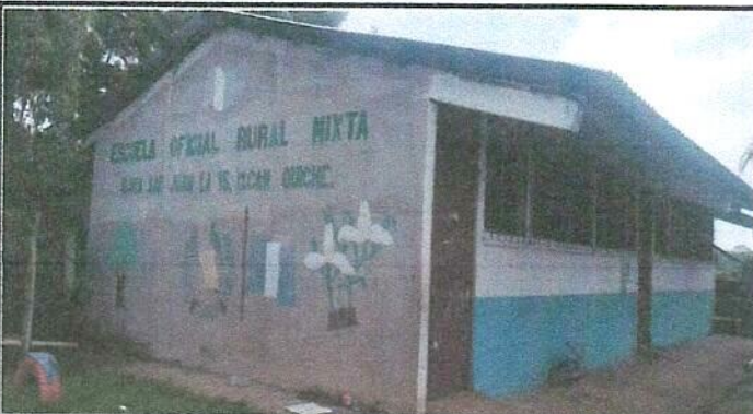
Foto 3: Pintura en muros exteriores e interiores del centro educativo
