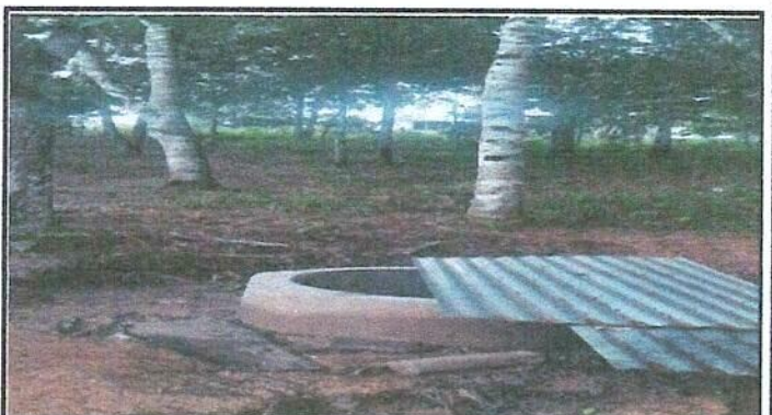
Foto 4: Instalación de tubería del pozo al centro educativo
