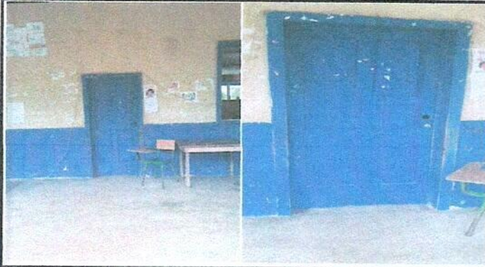
Foto 1: Sustitución de puertas de madera por metal
