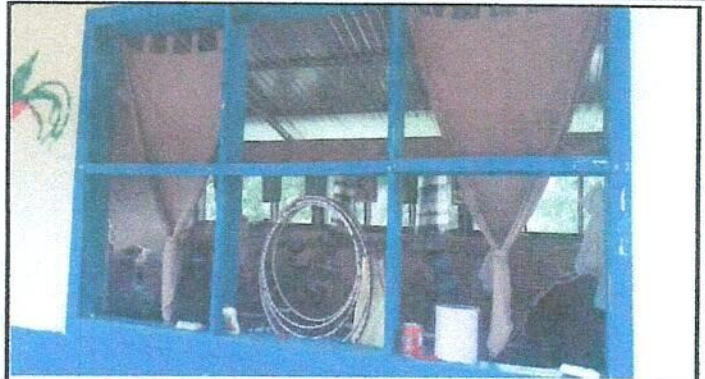
Foto 2: Sustitución de ventanas de madera con malla por balcones de metal
