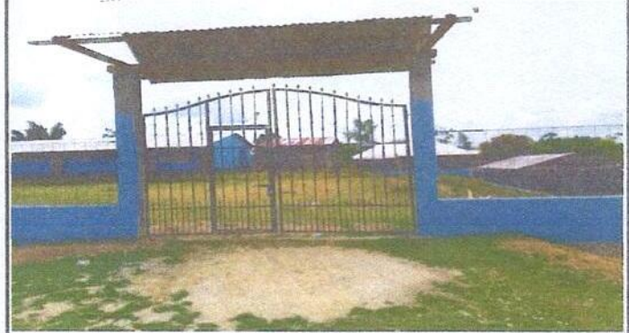
Foto 2: Sustitución de portón de metal (3.50 x 2.60)
