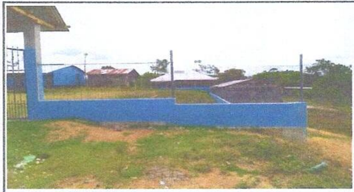
Foto 3: Pintura en muros exteriores e interiores
