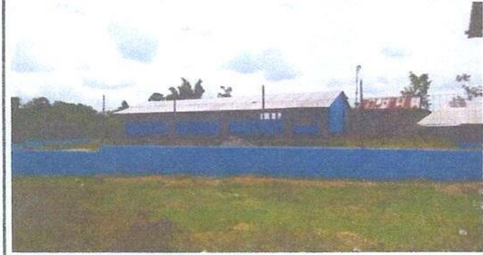
Foto 1: Sustitución de muro perimetral
