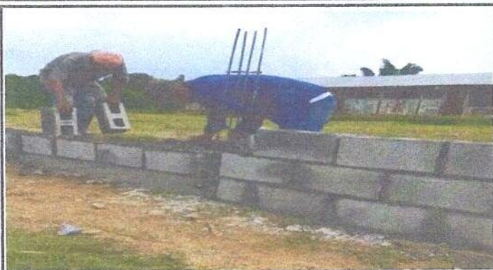
Foto1: Sustitución de muro perimetral
