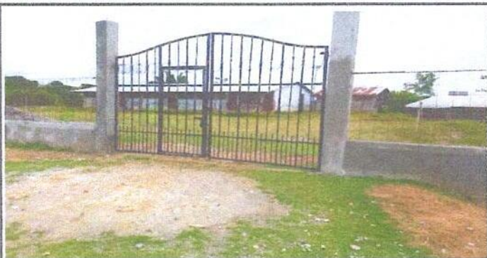
Foto 2: Sustitución de portón de metal (3.50 x 2.60)
