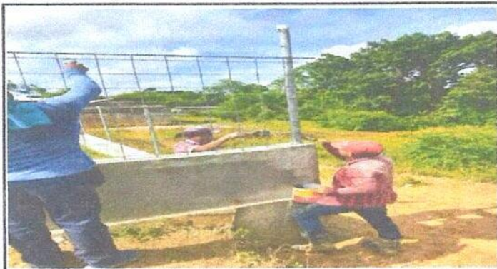
Foto 3: Pintura en muros exteriores e interiores
