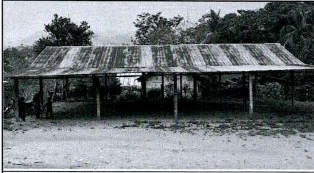
Foto 1: Sustrucción de lámina por lámina troquelada calibre 26.
