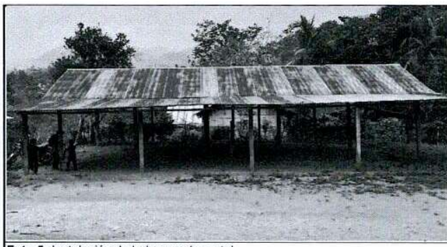
Foto 5: Instalación de balcones de metal.
