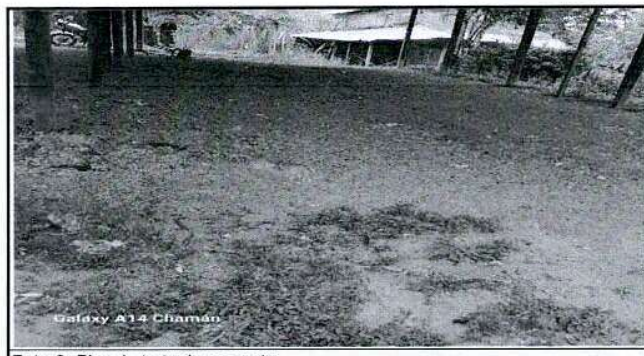
Foto 6: Piso de torta de concreto.
