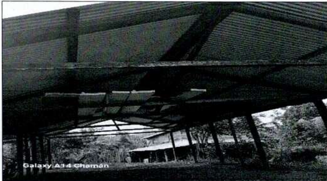
Foto 3: Sustrucción de estructura de madera por metal.
